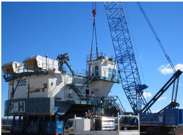
图一：吊装过程
