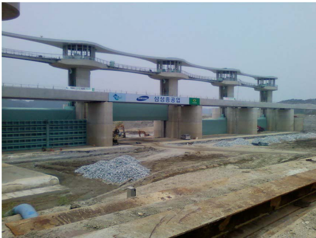
图一：正在建造的防洪闸门
